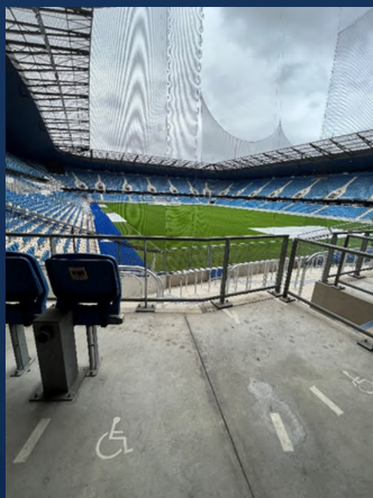
➤ 18 places PMR dans le secteur visiteur
